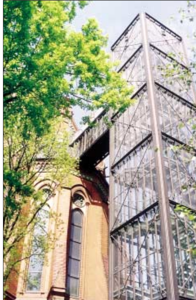
Neuer Treppenturm zur Erschließung des Dachraums der Heilig-Kreuz-Kirche in Berlin
